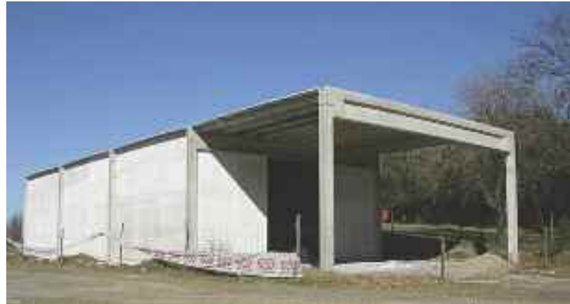
AVANCE DE OBRA EN EL MACU, UNQUILLO
